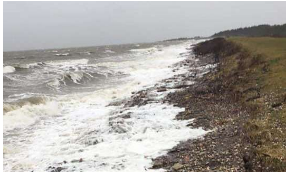
Figur nr. 1 Fotos der viser akut erosion i vinteren 20/21. FotoTaget af Kyst-havneviden den 20. maj 2021 i tidsrummet 13:45 - 14:15. Data til foto indeholder gps data, som kan fremsendes ved efterspørgsel.
