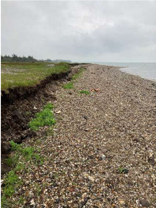
Figur 3 Diget, der eroderer.
