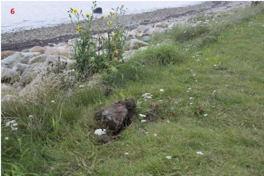
Et stykke beton.
