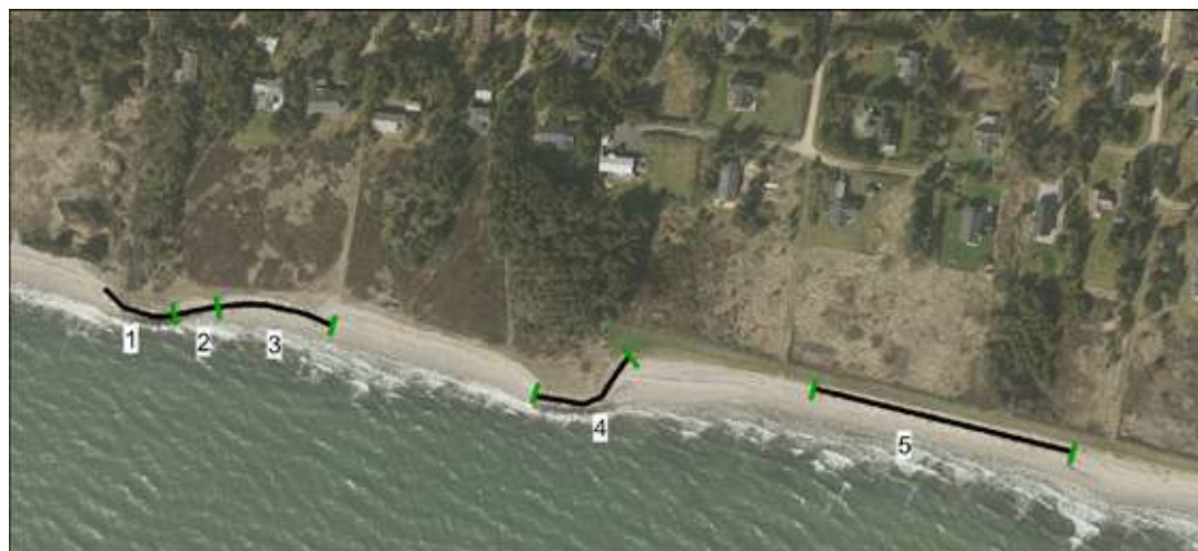
Figur nr. 8 viser eksisterende stenkastninger på strækningen
