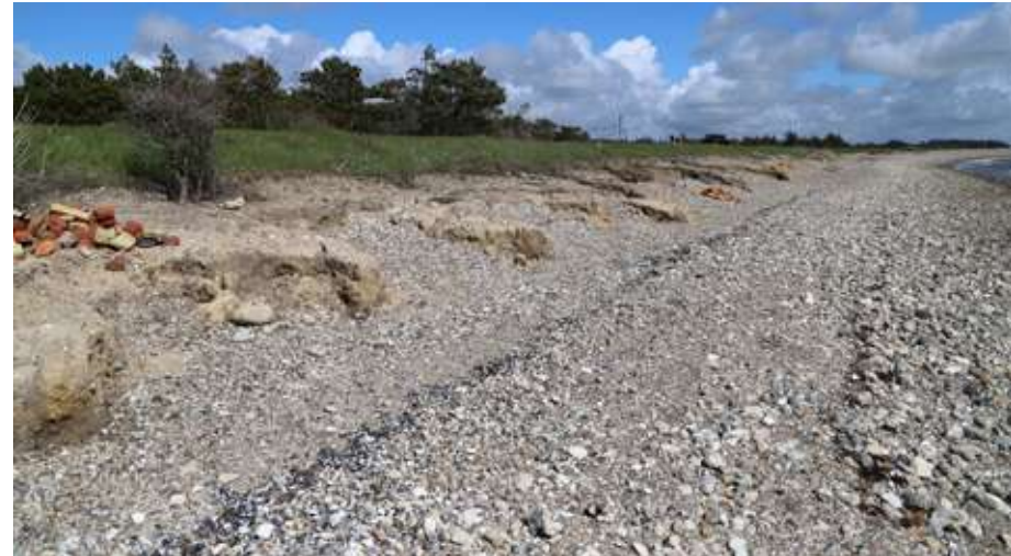
Figur nr. 4 T Fotos der viser akut erosion i vinterne 20/21. Fotoaget af Kyst-havneviden den 20. maj 2021 i tidsrummet 13:45 - 14:15. Data til foto indeholder gps data, som kan fremsendes ved efterspørgsel.
