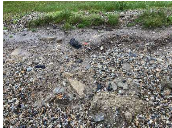
Figur 6 Diget, der eroderer. Byggeaffald, her beton, iblandet jorden.
